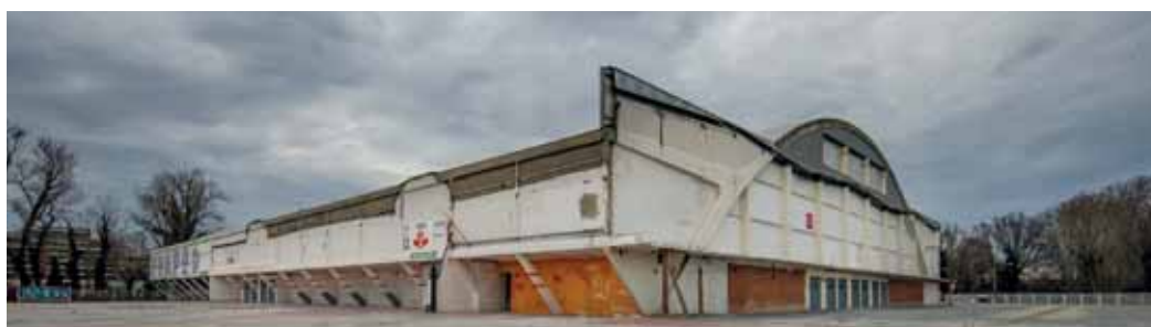
Déconstruction du parc des expositions de l'île du Ramier
