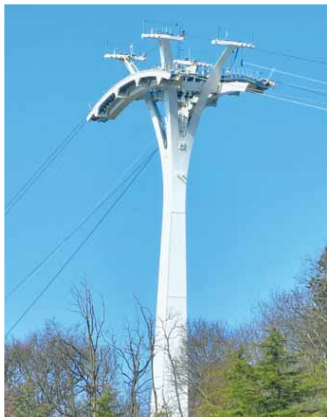
Chantier du téléphérique Téléo
